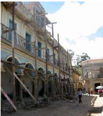
Foto 57: Refacción de edificio Municipal
