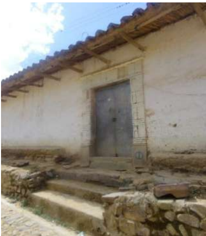
Foto 17: Portón con gradería en la Calle Sucre
