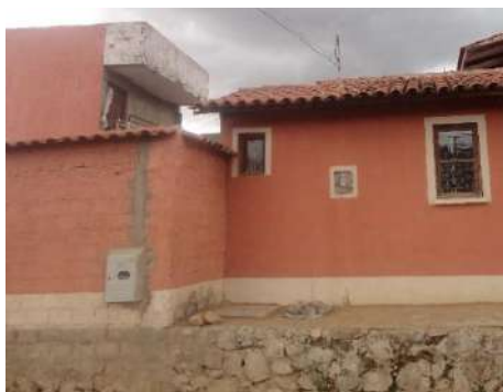
Foto 76: Gas domiciliario en casa refaccionada
