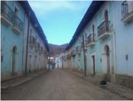
Foto 15: Balcones de hierro forjado
