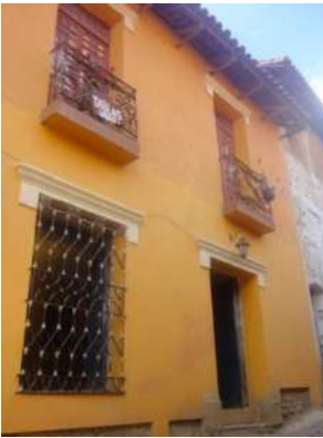
Foto 26: Arreglos recientes en la Casa de Tablas
