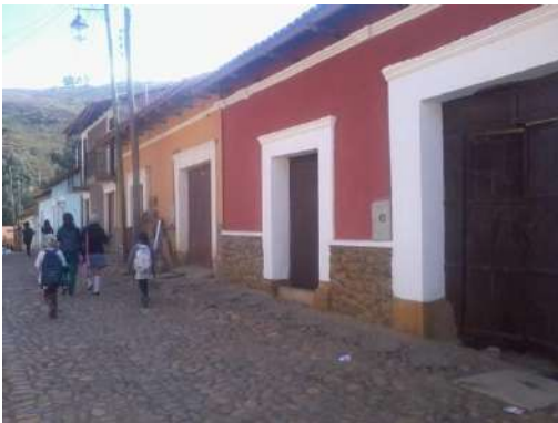
Foto 18: Casas conservadas en la calle Cochabamba
