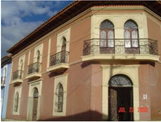
Foto 5: Fachada Este de la Casa
