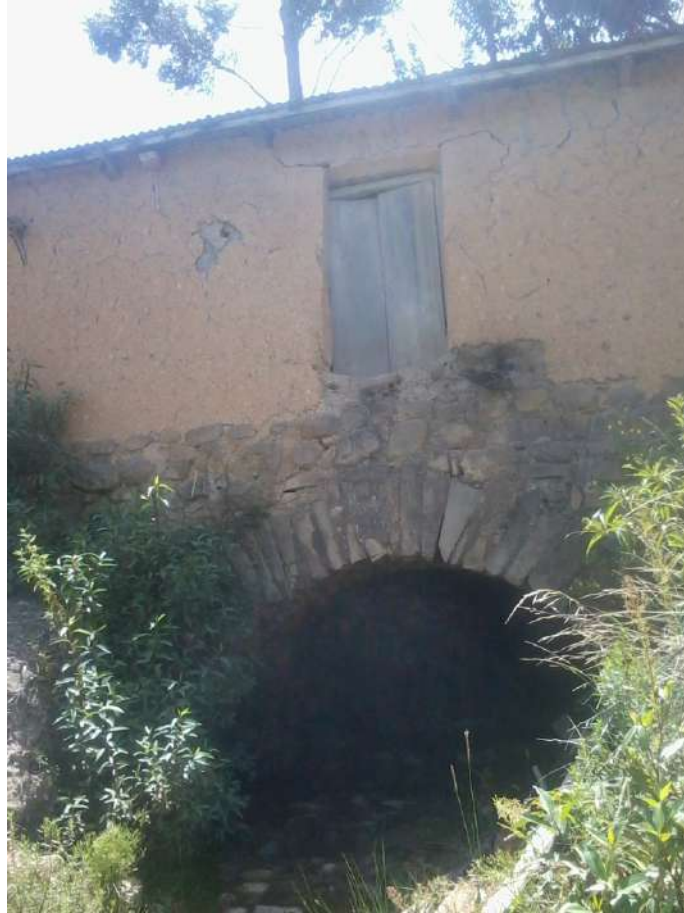
Foto 7, Vista exterior con cámara del rodezno en Rodeo Grande 1
