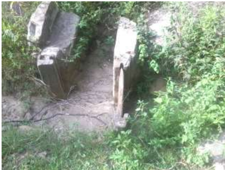
Foto 12: Toma de agua con compuerta móvil de madera
