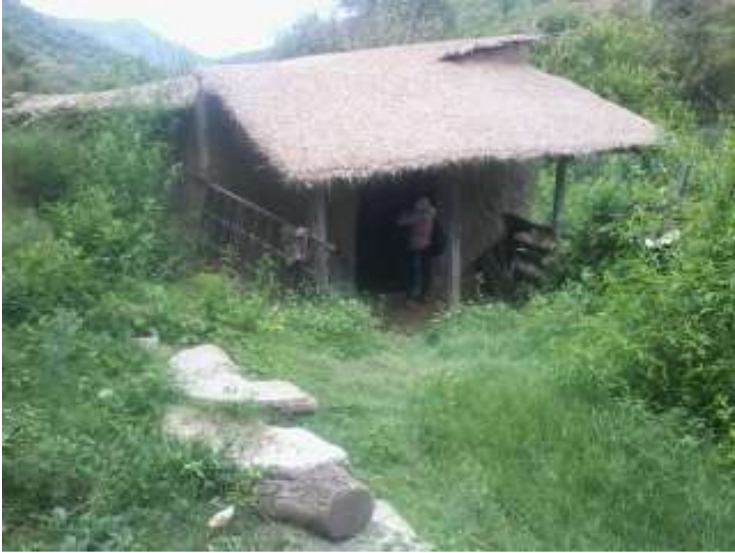
Foto 21, Zaguán de descanso en el portal del Molino de Huertamayu
